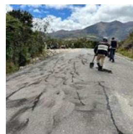
e). Sello de Fisuras
